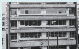
昭和37年 本社ビル
