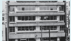
昭和37年 本社ビル
