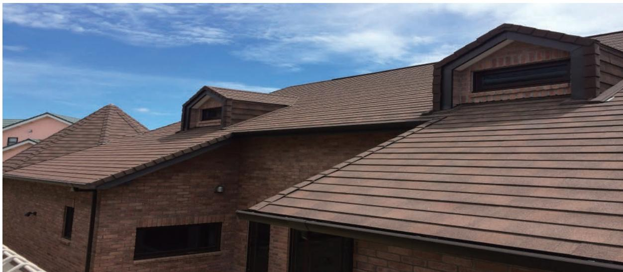
非常に軽量の金属を基材とし、表層に石粒をコーティングした高耐久金属屋根材
