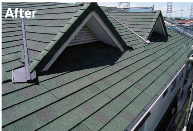
②既存屋根を撤去せず、カバー工法が可能
