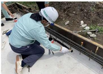
①ベースコンクリートへ専用プライマー塗布 ※塗布幅 約50mm
