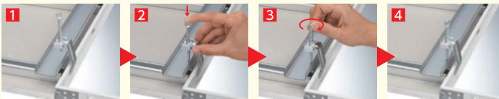
ハンガーを外枠にセットします。ハンガーボルトを取付野縁に当たるところまでスライドさせます。ハンガーボルトを数回回し締めます。完了。
