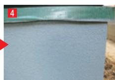
4 施工後24時間程度(気温20℃程度)は雨等がかからない様にマスキング等で養生して下さい。
